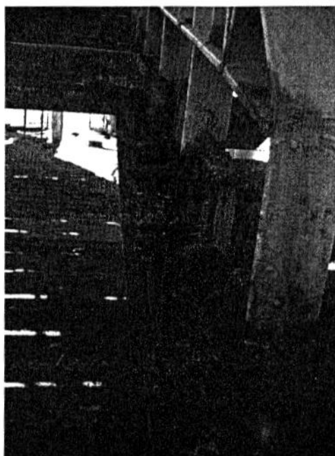
Fot. 2. Stan konstrukcji podparcia i mocowania stopni w części środkowej – po demontażu stopni.
