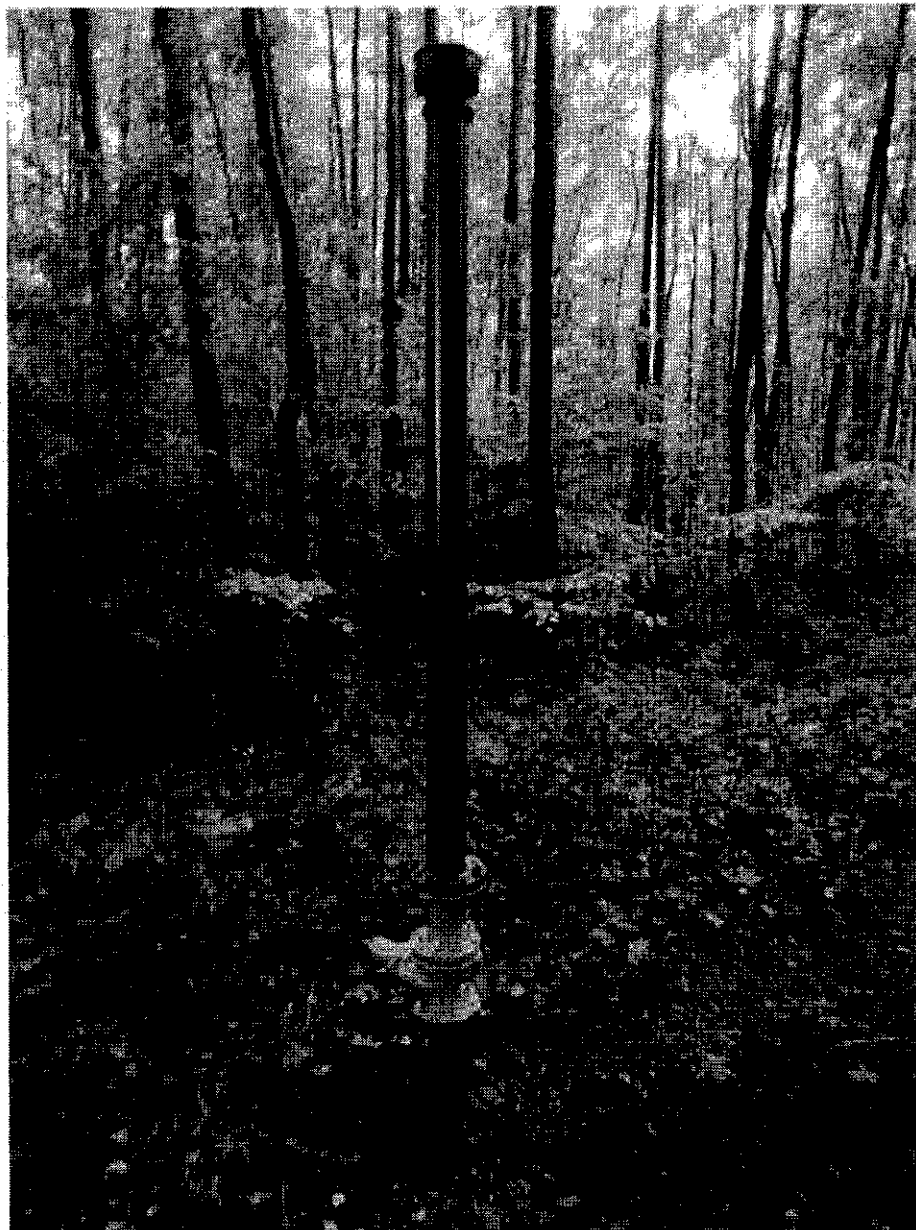
Odpowietrznik z zamontowanym biofiltrem
